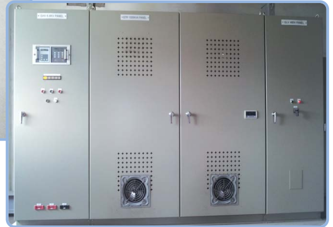
▼ 내부 과도열 환풍기 설치
