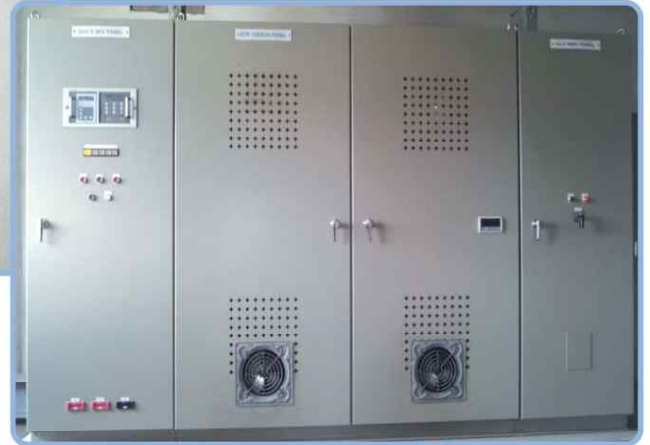
▼ 내부 과도열 환풍기 설치
